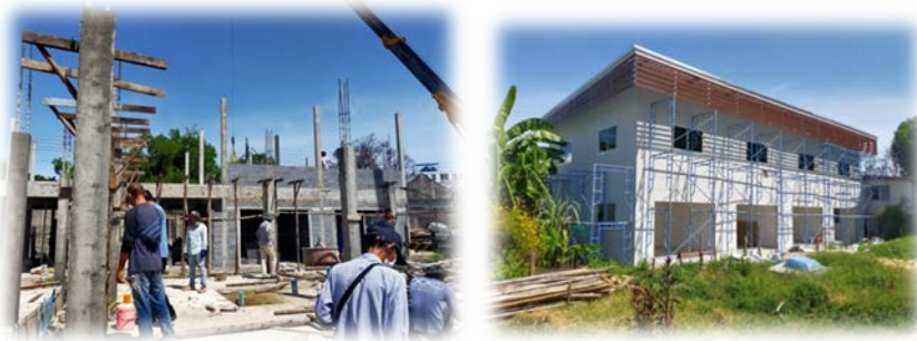
แบบบ้านระหว่างก่อสร้าง
